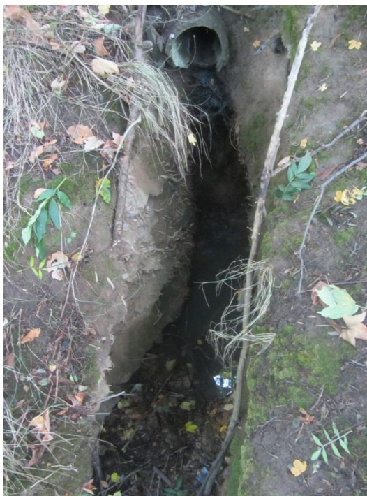
Foto 6: Detailní pohled na stávající vyústění dešťových svodů DN 300 (10. 10. 2016)
