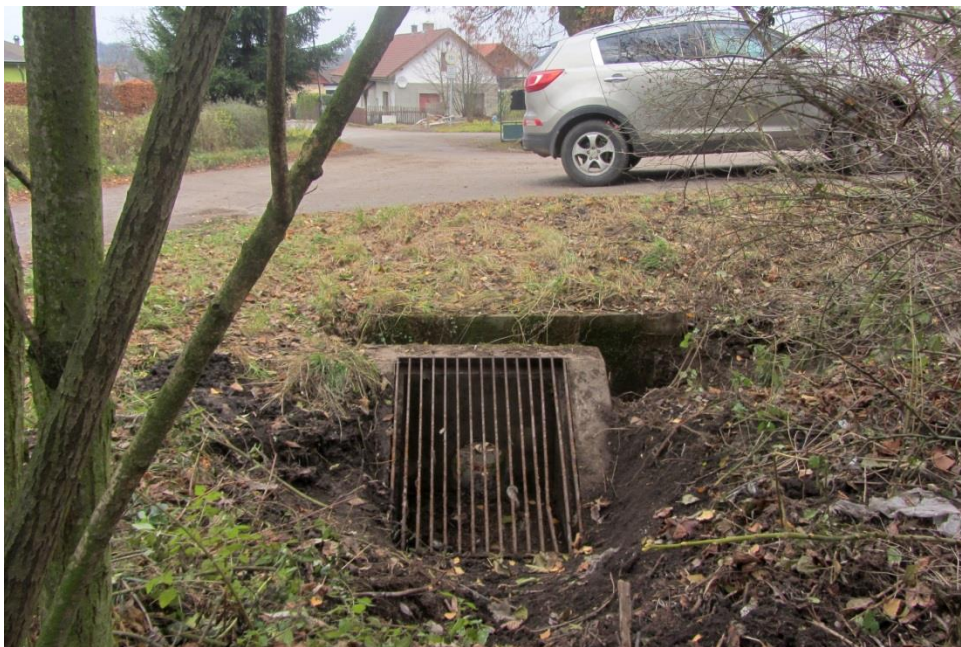
Foto 3: Stávající lapač splavenin – pohled po směru toku vody (22. 11. 2016)
