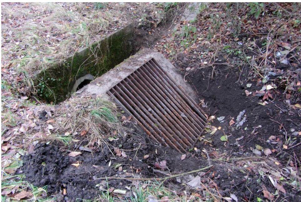
Foto 2: Stávající lapač splavenin (22. 11. 2016)
